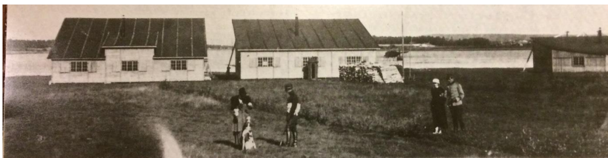
För sommaren 1917 var äntligen tre uppvärmbara trähangarer uppförda vid Bodträsket
