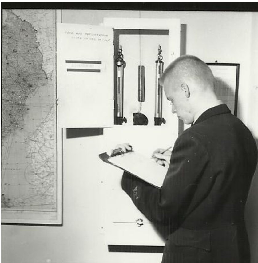
Lufttrycket lästes av på en Barometer som bestod av ett kärl med kvicksilver och ett glaströr som kvicksilvret pressades upp i av luften. Vid högtryck lång pelare vid lågtryck låg pelare. För att göra en väldigt enkel beskrivning av instrumentet.
