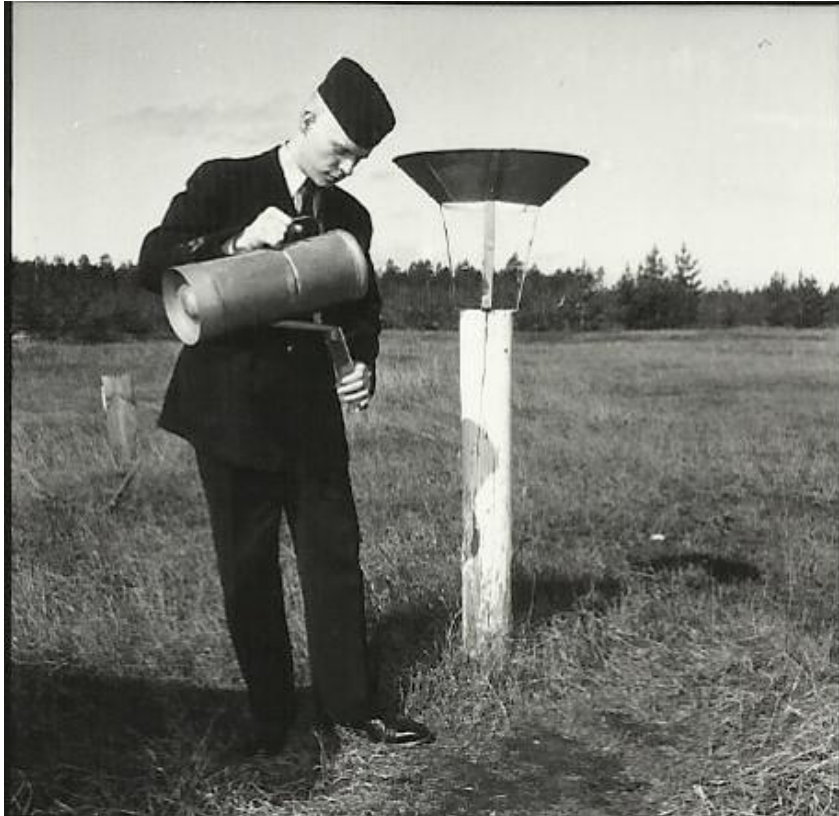
Klockan 07 och klockan 19 mätte man nederbörden genom att hälla vattnet från uppsamlingskärlet i ett märglas som var graderat i tiondels millimetrar. En liknande nederbördsjätmätare finns vid Flygmuseet F 21.
