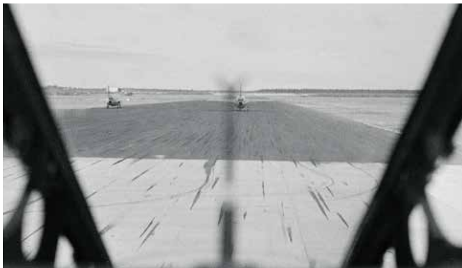
S 29C Tunnan klara för start på Kallax bana 32. Banändorna är betongbelagda på grund av flygplanens bränslespill. Foto i F 21:s arkiv.
